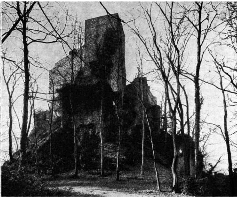
4. Burgruine Hohenbaden Blick vom Halsgiaben auf die romanische Oberburg mit Bergfrit und angebauter Schildmauer
