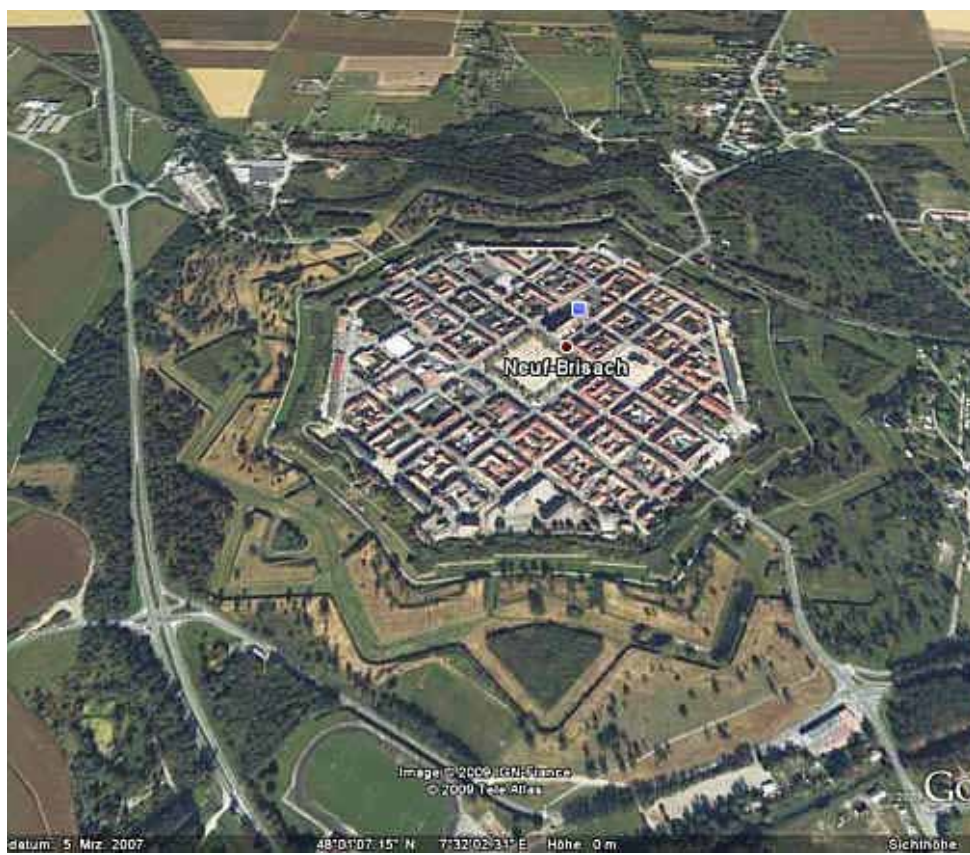
Neu-Breisach, die reifste Fe- stungsanlage Vaubans. Oben ein Ideal- plan des frühen 18. Jahrhun- derts, links das Satellitenbild.
