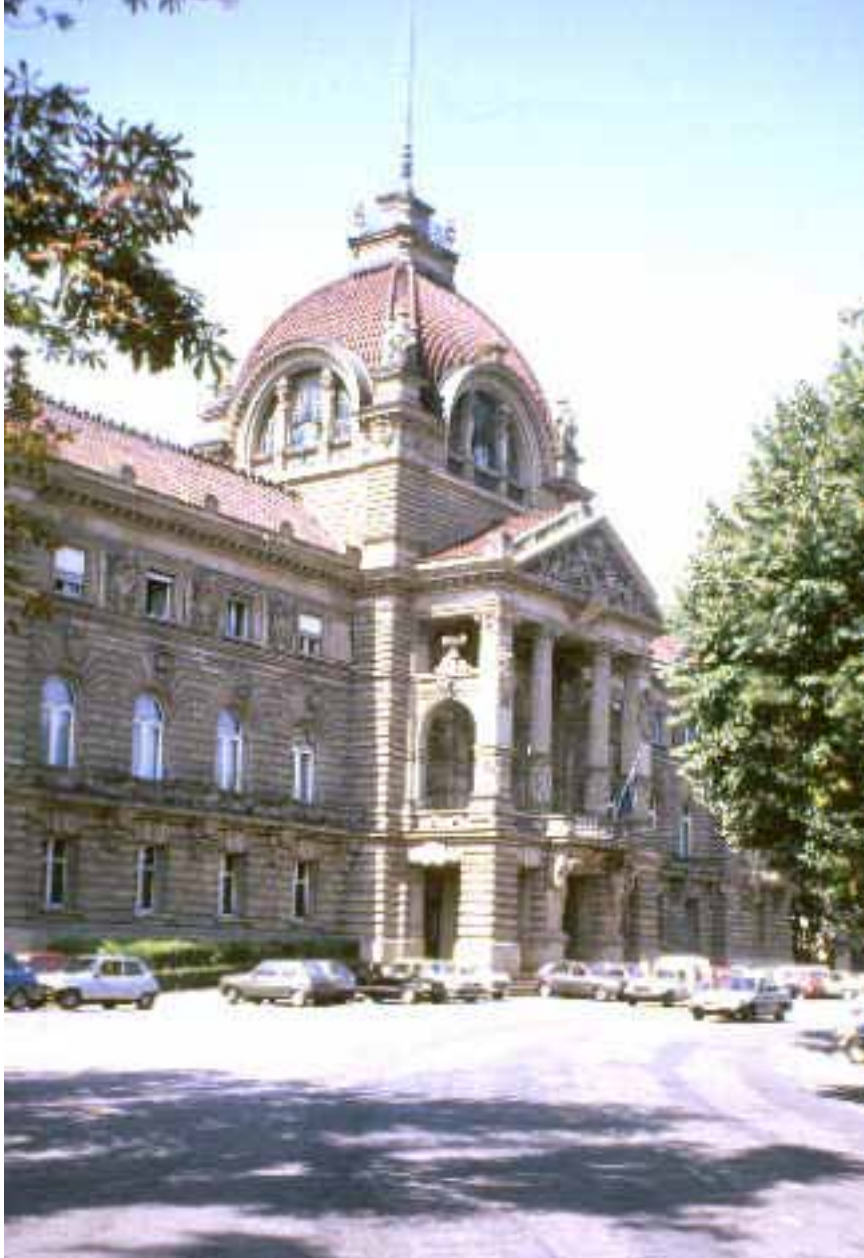
Straßburg, Palais du Rhin, ehemaliger kaiserlicher Palast
